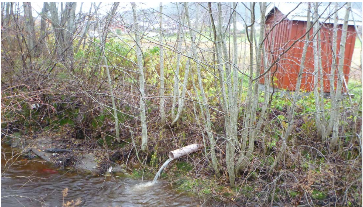
Figur 54. Flere utslippsrør med potensiell sanitært avløpsvann går rett i Hubekken, her fra strekninger nedstrøms Fv. 50. (Foto: Morten Bergan)
