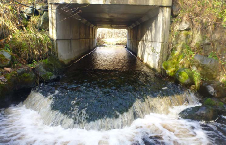
Figur 34. Krysning under Fv 231 i Eidselva på over middels/høy vannføring og mulige oppgangsforhold for sjøørret. (Foto: Morten Andre Bergan)
