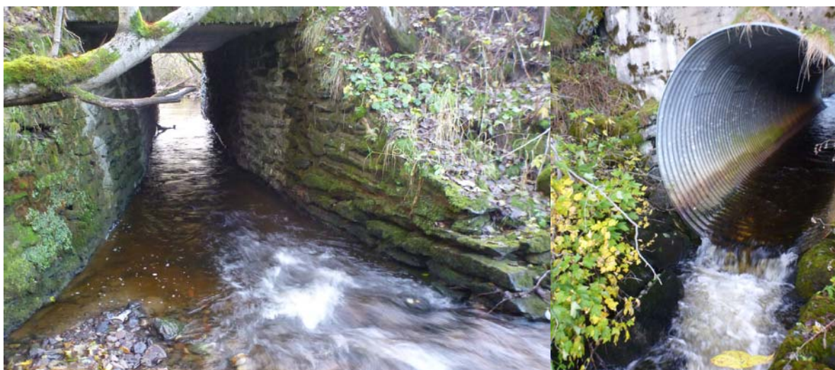
Figur 18. Veikrysninger under hhv. Modalsveien (t.v.) og Denstadveien (t.h.). Foto: M. Bergan
