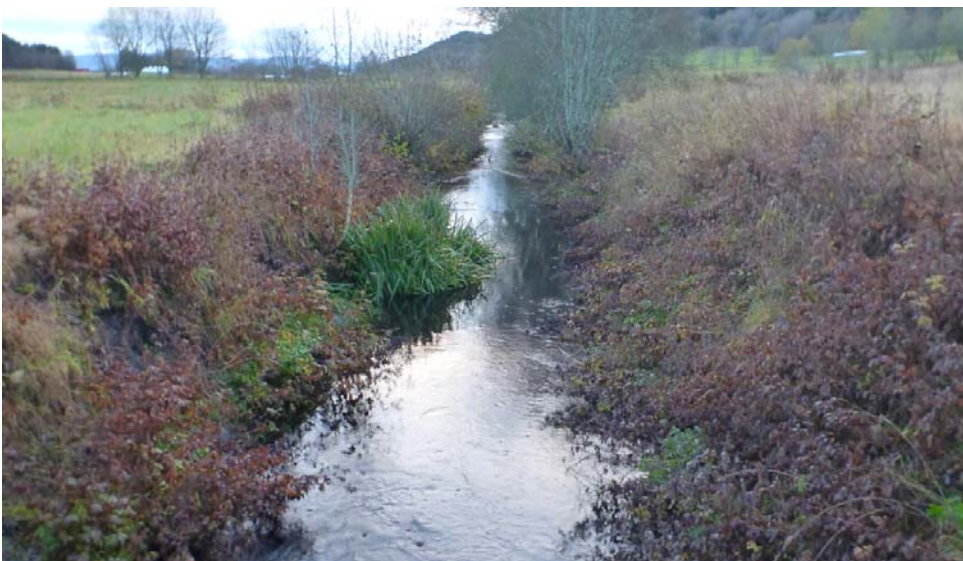
Figur 36. Store deler av Eidselva er grøftet ut og kanalisert sammenlignet med naturtilstand. Dette gir «svært dårlig» hydromorfologisk status og uegnete gyteforhold for laksefisk. Foto: Morten Bergan.
