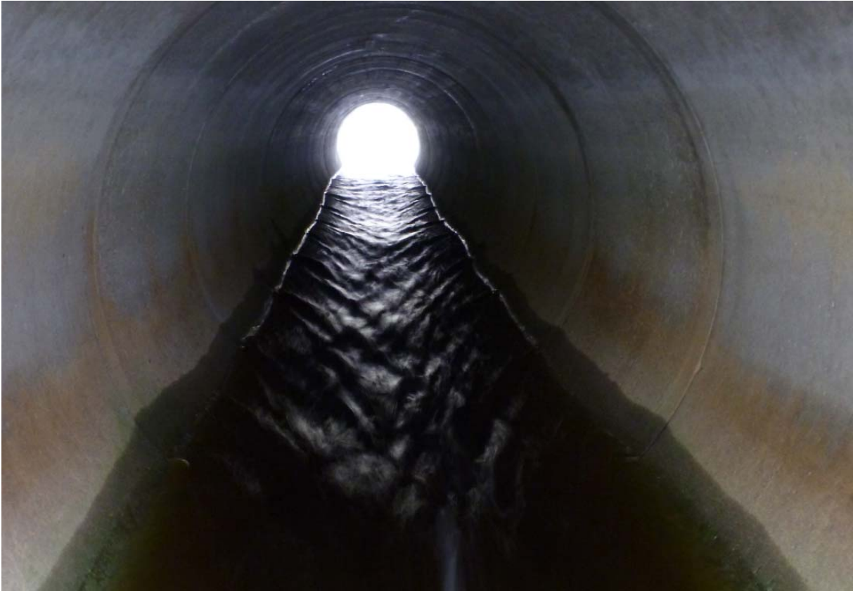
Figur 57. Krysning under Hubakkveien er ikke vandringshindrende på normale vannføringer. (Foto: Morten Bergan)
