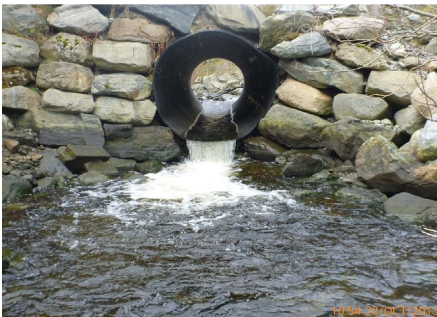
Figur 63. Kulvert i Sætranselva før munning til sjø.
