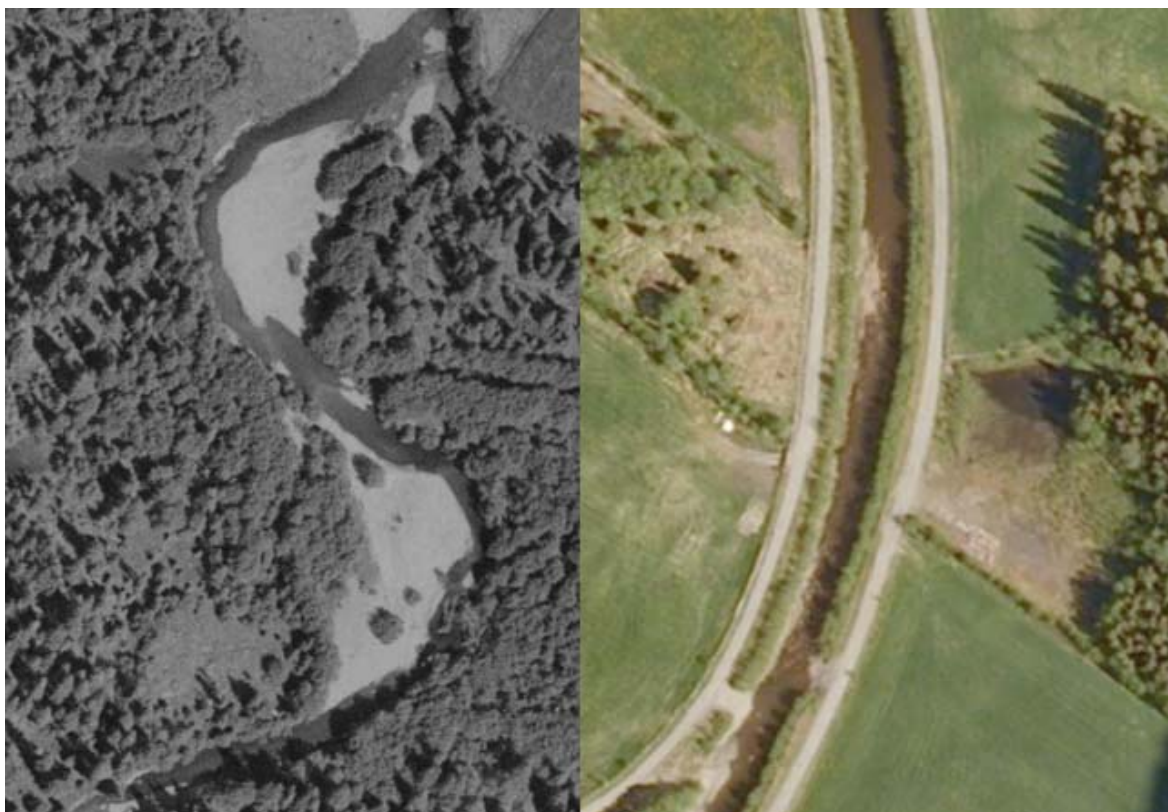
Figur 76. Flyfoto fra øvre deler av Straumselva oppstrøms Straumsvatnet. Elva er endret og utrettet til det ugjenkjennelige fra 1971 (t.v.) fram til 2008 (t.h.). Flyfoto hentet fra http://kart.finn.no/ .
