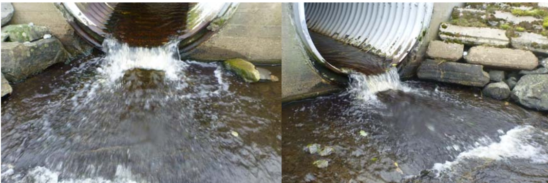
Figur 82. Veikulverten er utformet med to parallelle blikkrør, noe som ikke er en gunstig utforming mht. fiskevandring. (Foto: Morten Bergan)
