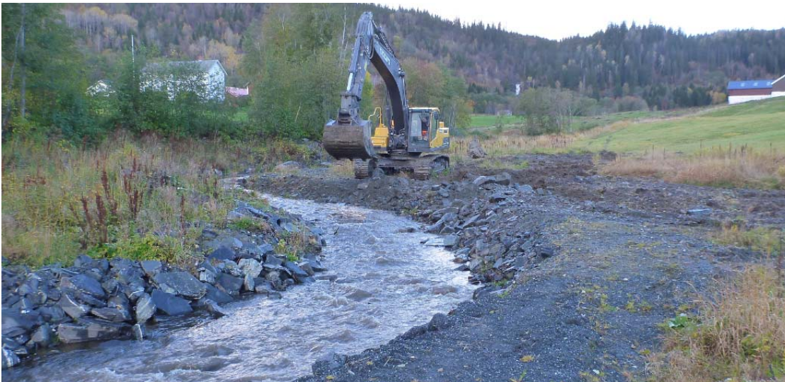
Figur 5. Øvre, nylig steinsatte strekninger av Prestelva, og pågående anleggsarbeid i og ved elva midt i gytetiden for sjøørret og laks. (Foto: M. Bergan)
