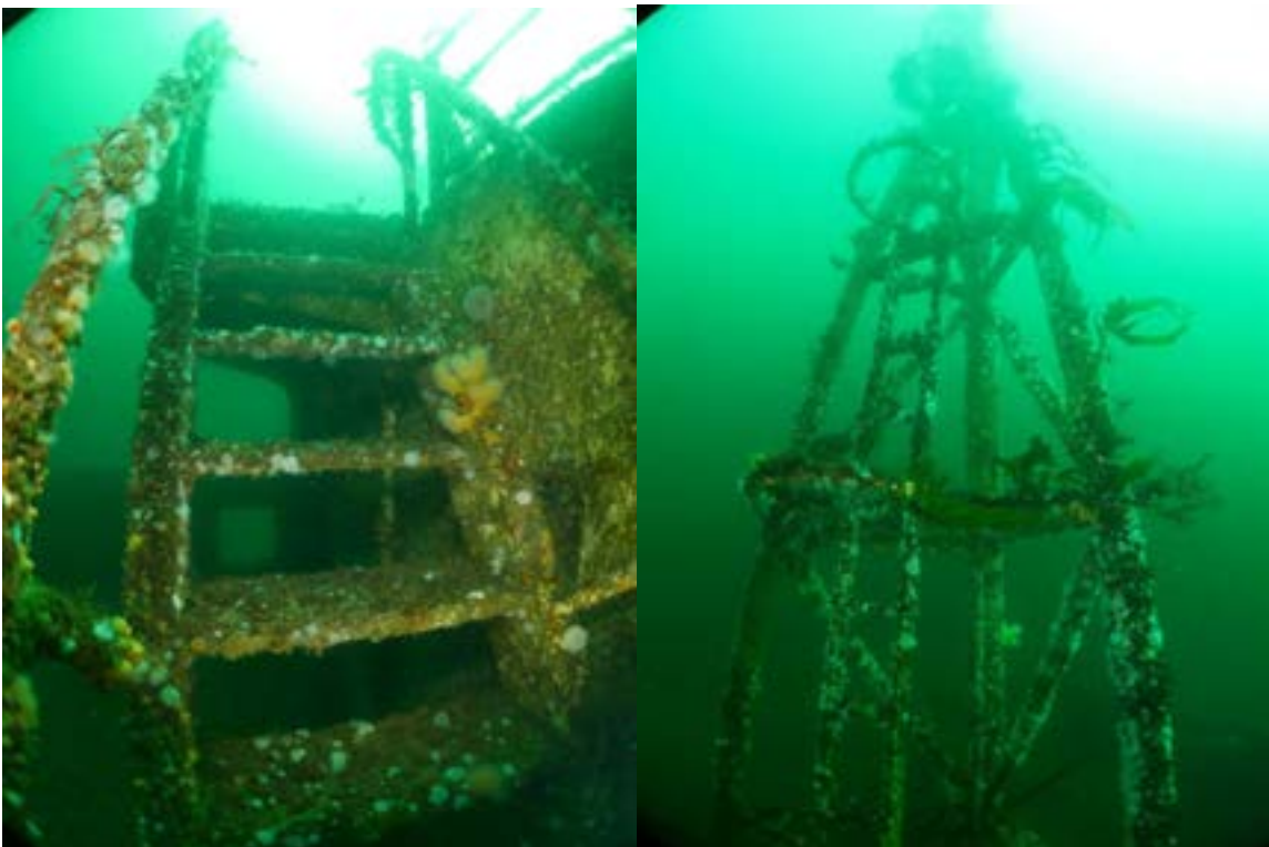
Trapper, rekkverk og master bevokst av sjøanemoner, koralldyr og tare i tillegg til andre alger (Foto: Janne K Gitmark, NIVA).
