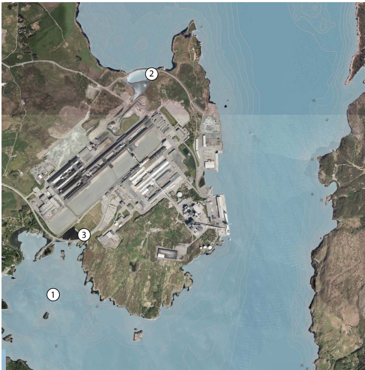
Figur 2. Beliggenheten av aluminiumsverket på Karmøy. Bildet viser de to sedimentasjonsbassengene hhv nord (2) og syd (3) for verket. Lekkasje fra disse sedimentasjonsbassengene fører forurenset vann til Karmsundet. Pkt 1 viser posisjon for sjøvannsinntak til bedriften. Kartgrunnlag fra www.kystverket.no .
