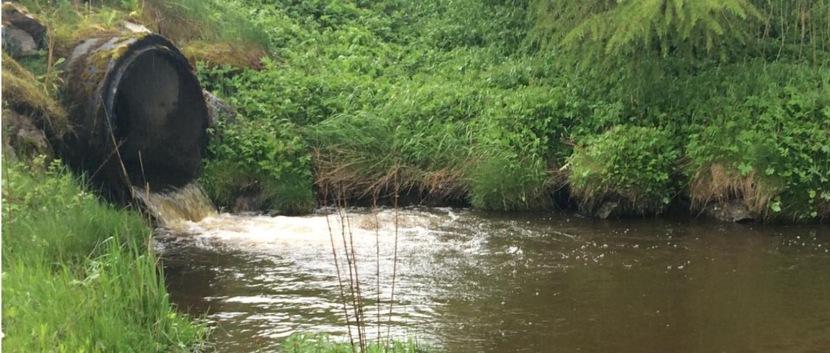
Figur 17. Kulvert under Fv 714.
