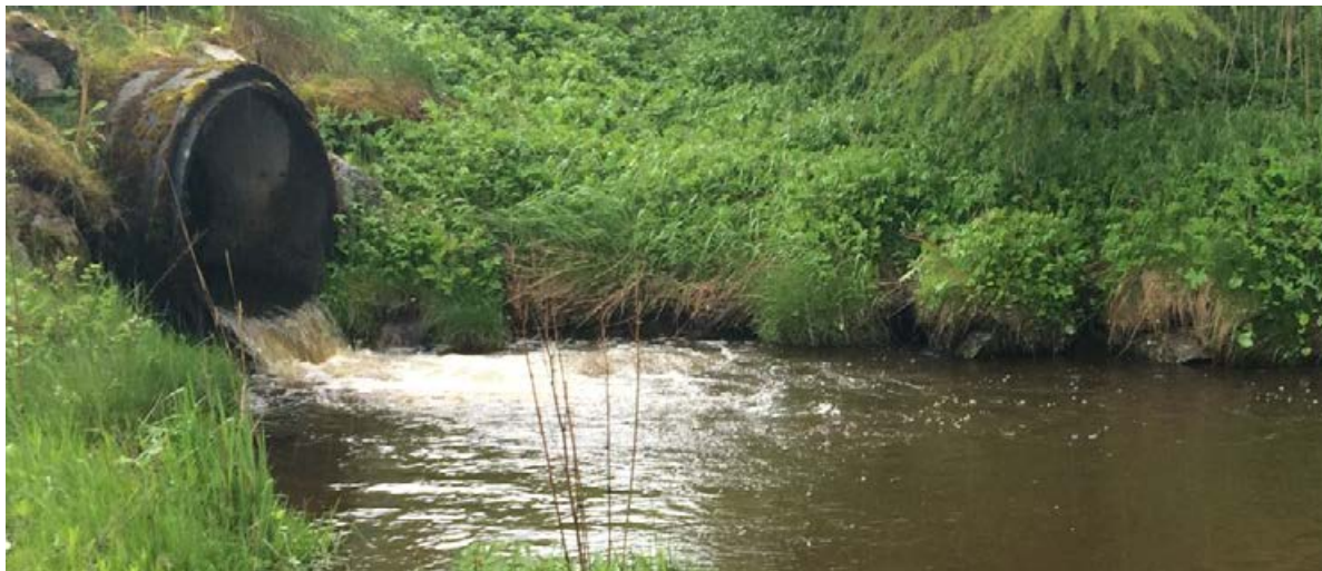
Figur 17. Kulvert under Fv 714.
