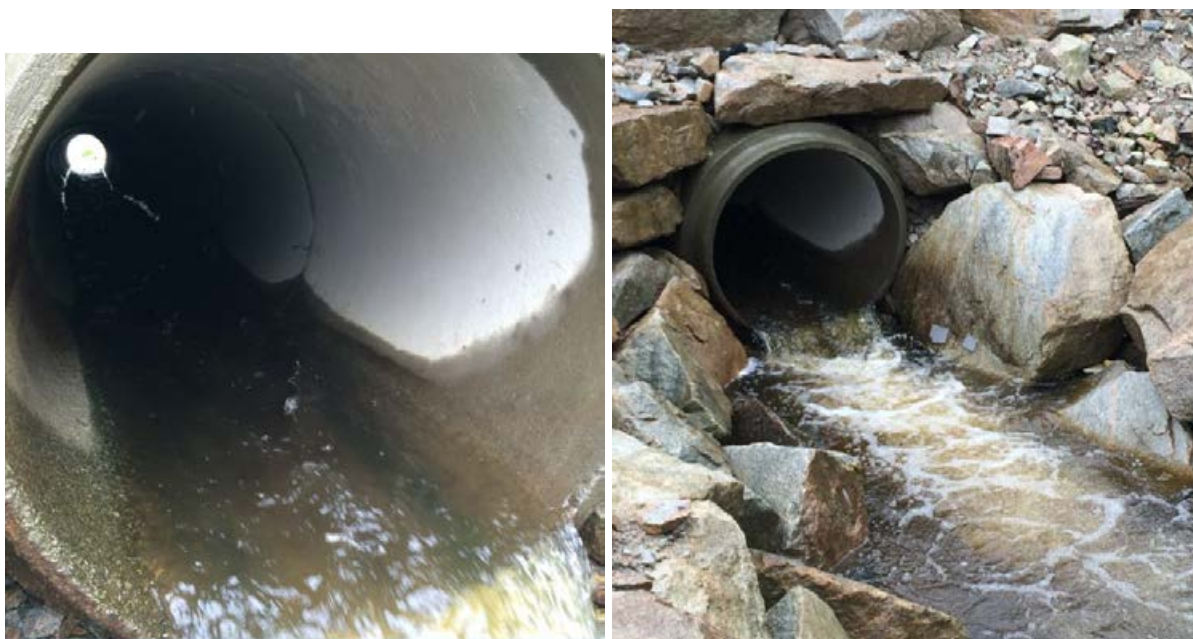
Fig 18. Nyetablert kulvert under vei inn til HAMOS sin miljøstasjon.
