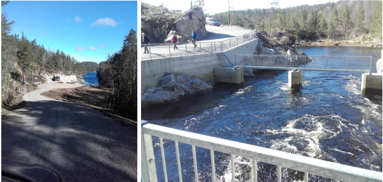
Figur 4. Skripelandsfossen Kraftverk. Venstre: Inntaksområdet for vann til kraftverket. Høyre: Utslaget fra kraftverket
