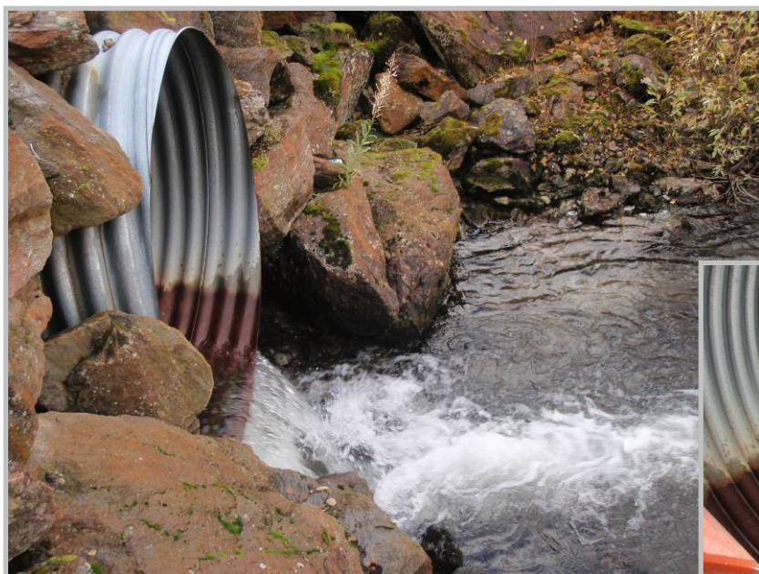
Figur 19. Kulvert nedstrøms demning (Foto: Morten Andre Bergan).
