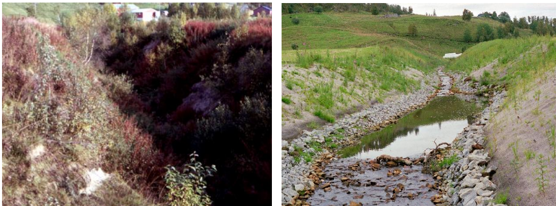
Figur 2 . Jordbrukskanalen fra Bruksåsmoen før og etter at tiltak ble gjennomført for å stoppe erosjon og slamtransport fra denne til Børselva. (Foto K. J. Aanes)
