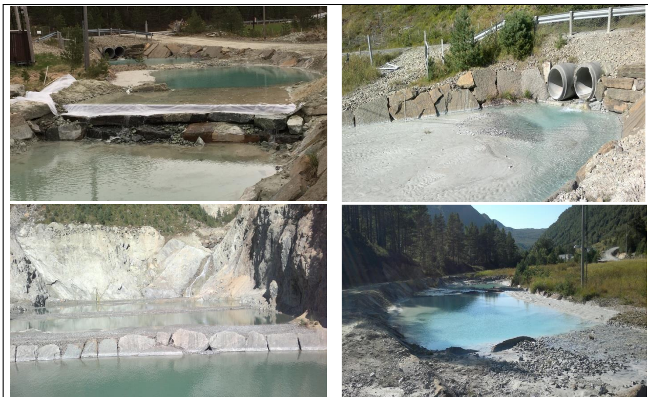
Figur 26. Ulike tiltak for å redusere transporten av uorganisk partikulært materiale fra dagbruddet i GUSDALEN. Foto: K. J. Aanes.
