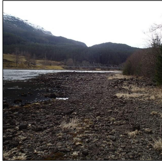
Figur 11. Stasjon OV 6 Lindum, med hengebrua nedstrøms stasjonen
