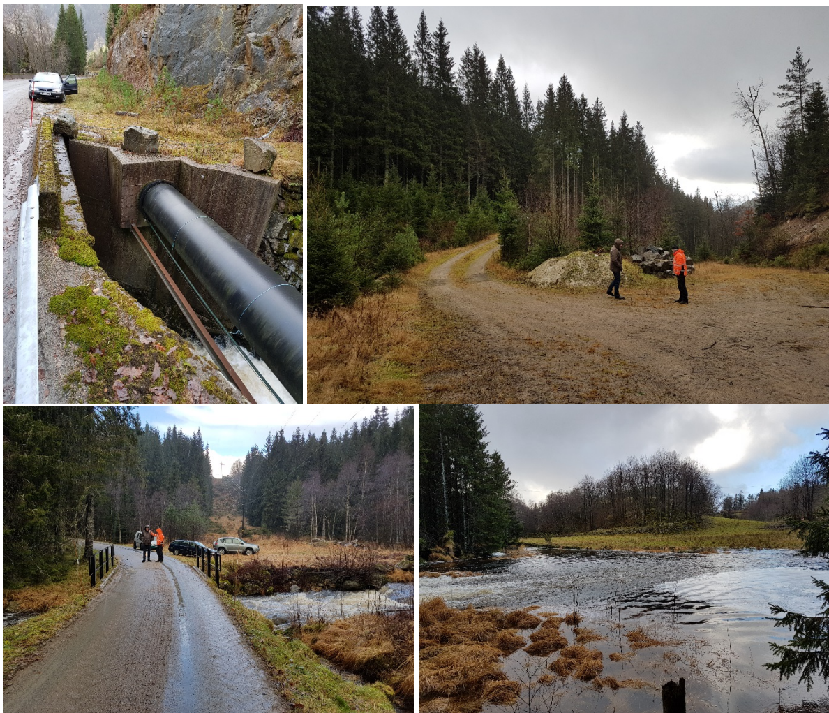
Figur 2. Bilder fra Spillingsbekken. Synlig kraftverksrørgate ved utløpet av Libekken (øverst til venstre), Holtet, Libekken (øverst til høyre), Storebekken ved Velte (nederst til venstre) og Tjomsland og Torslona i Storebekken (nederst til høyre).
