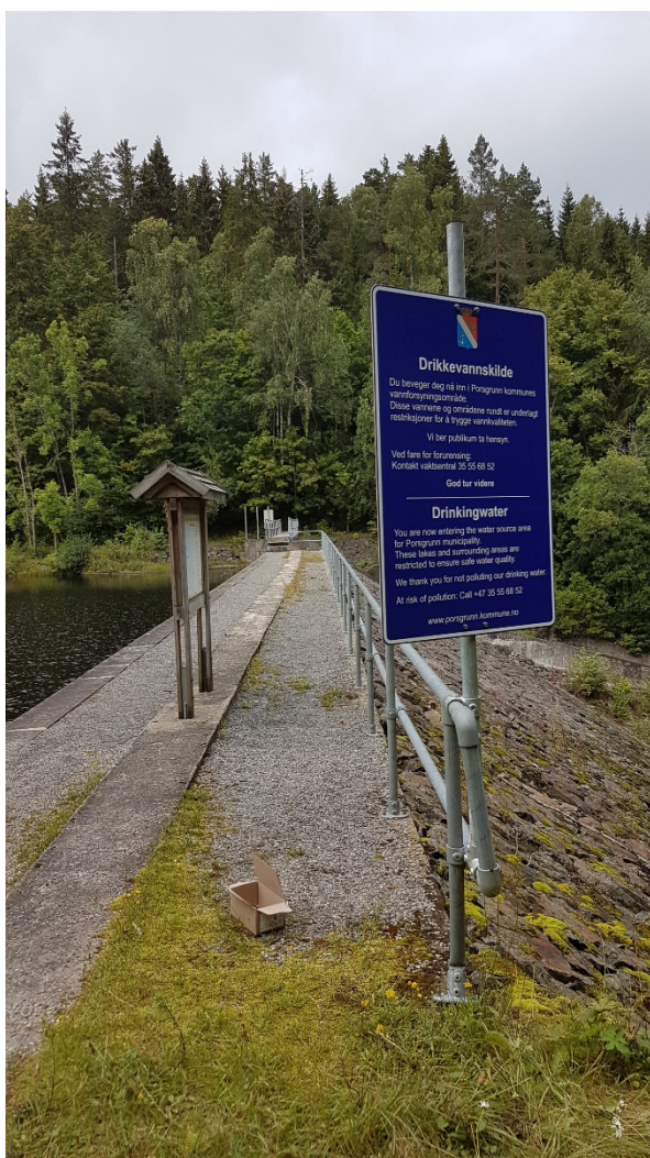
Figur 8. Det er satt opp nye skilt på Skifjell, på veien inn mot Lille Skifjell og her ved Mjøvannsdammen. Foto: Porsgrunn kommune.
