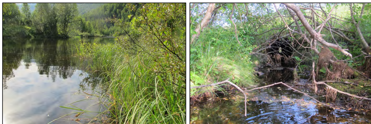
Figur 17. Kjosens sett mot vest (venstre) og kulverten i utløpet (høyre).
