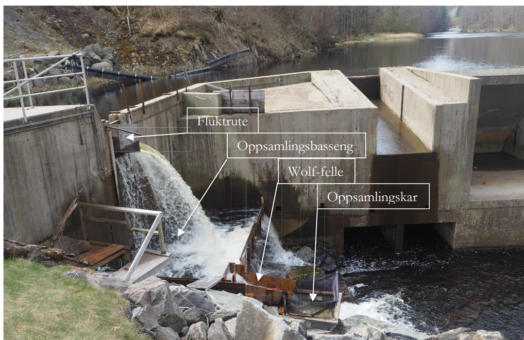
Figur 2. Fosstveit kraftverk med fluktrute for utvandrende smolt, oppsamlingsbasseng, Wolf-felle og oppsamlingskar for smolt.
