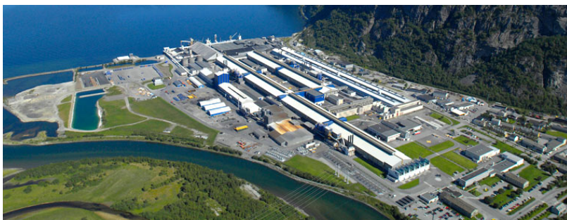
Figur 2. Oversiktsbilde av produksjonsanlegget til Hydro Aluminium Sunndal på Sunndalsøra.
