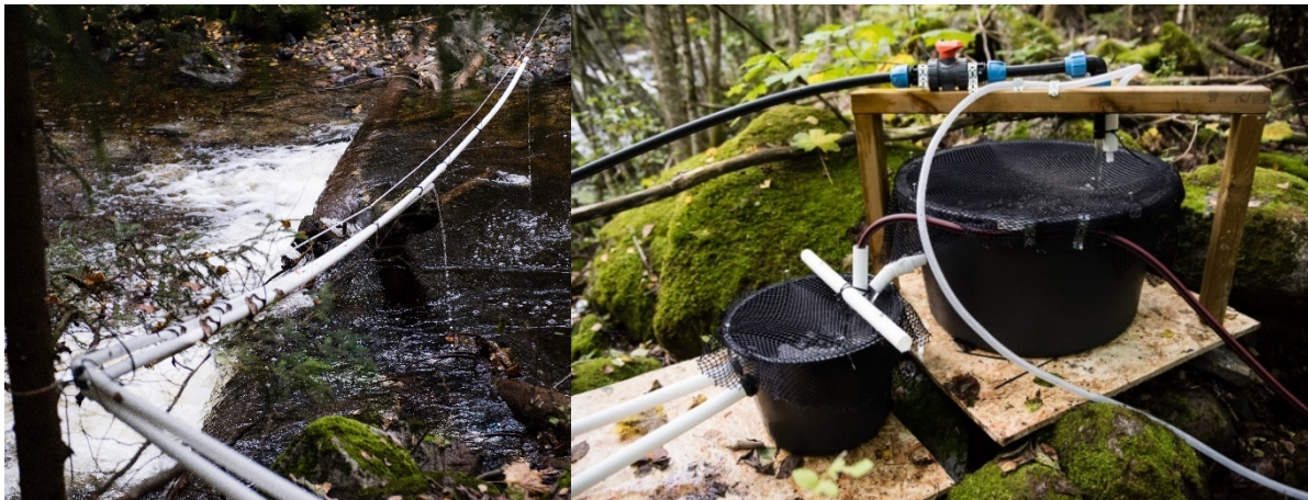
Figur 4. Bilder fra dosering av monokloramin. Bildet til høyre viser systemet for produksjon av monokloramin. Vann fra elva ble pumpet opp i den største murstampen. Der ble ammoniumklorid tilsatt, før løsningen ble ledet ned i den minste murstampen. Der ble natriumhypokloritt tilsatt slik at det ble dannet monokloramin. Bildet til venstre viser rørsystemet som ledet monokloraminløsningen fra den minste murstampen ut i elven i to punkter. Foto: Anders Gjørwad Hagen/NIVA
