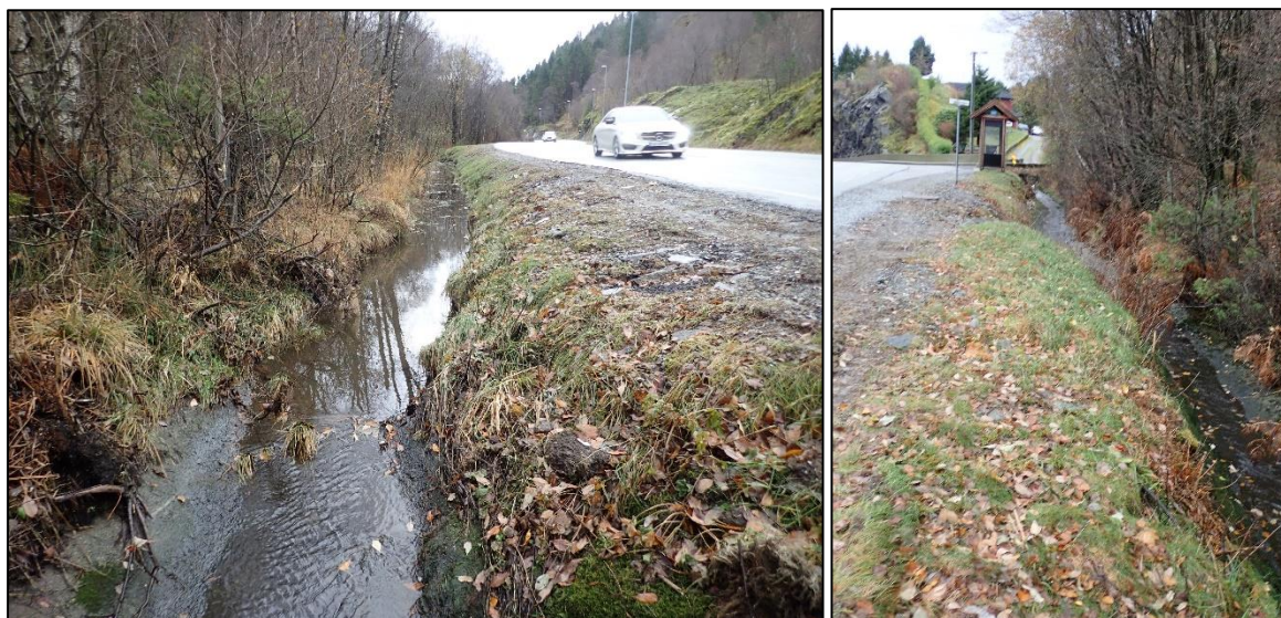
Figur 3. Til venstre bekk langs Salhusvegen sett oppover retning mot Ulset. Dette er St. 1 for vannprøvetaking. Til høyre det samme strekket sett nedover retning Hitland. Litt nedenfor busskuret svinger bekken av fra veien og inn i rør under avkjørsel og bebyggelse. Foto: AH 31.10.18.
