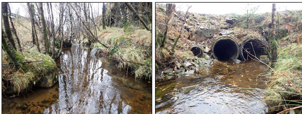
Figur 8. Bekken fra Mardalen like før innløp i rør under Salhusvegen, sett oppstrøms (til venstre) og nedstrøms mot rørintaket som fører under Salhusvegen til Ulsetstemma (til høyre). Dette er St. 5 for vannprøver og bunndyr. Autovernet langs Salhusvegen er synlig øverst til venstre. Foto AH 31.10.18.
