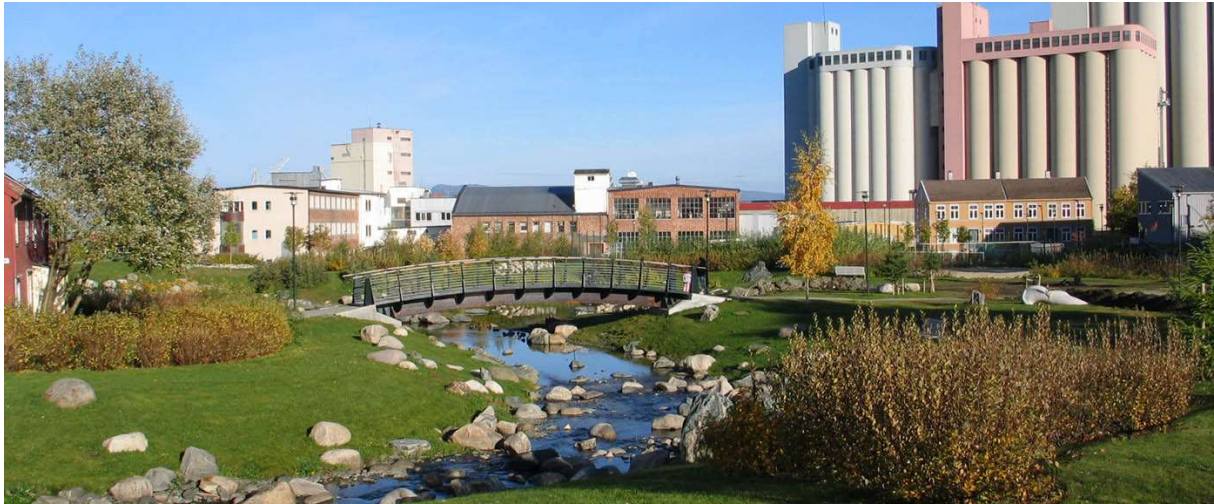
Figur 13. Ilabekken renner fra Bymarka i Trondheim og ut til Trondheimsfjorden ved Ilsvikøra på vestsiden av Trondheim sentrum. Bekken gikk tidligere bl.a. i en 700 meter lang kulvert før utløpet til fjorden. I 2006 ble bekken gjenåpnet. Bekken har erosjonssikring for å tåle en tusenårsflom og kantsonen er utformet så naturlig som mulig i forhold til gitte hydrauliske forhold (Foto: Mette Wormdal, Multiconsult).
