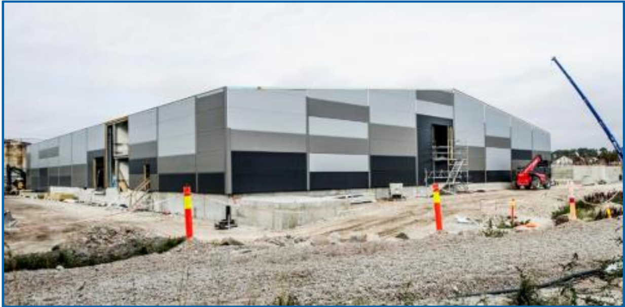
Figur 4. Fredrikstad Seafood sitt anlegg under oppføring på Øra i 2018. Foto: Fredrikstad Blad.
