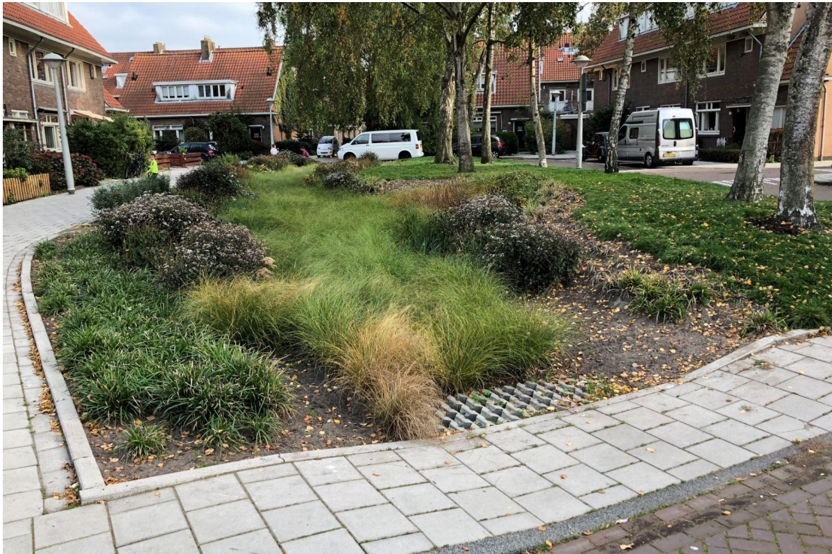
Figur 19. Stort regnbed som er etablert på tidligere P-plasser samler og infiltrerer overvann fra et boligområde (Harkstraat, Amsterdam).
