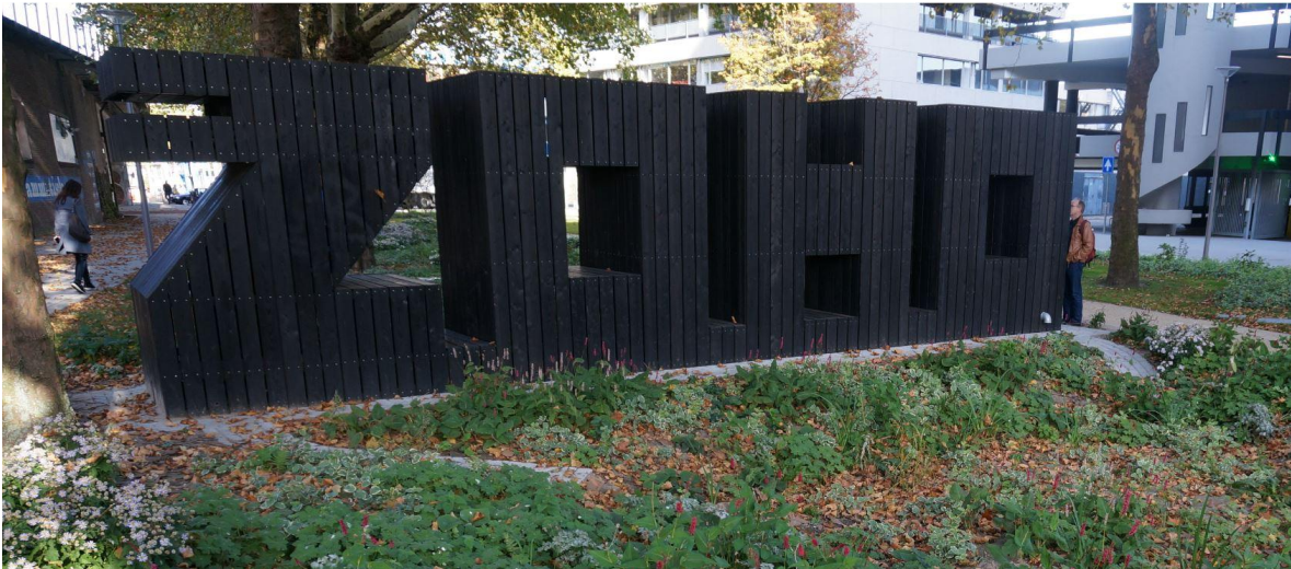
Figur 39. I bokstavene gjemmer det seg regnvannstøtter som mottar vann fra Hofbogen «skywalk». Vannet ledes ut i regnbedet som bokstavene er en del av 10 .
