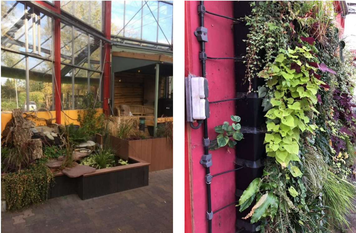
Figur 14. Regnhage og grønn vegg som mottar regnvann som fordeles vi rør og pumpe.
