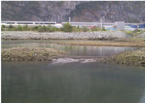
Figur 4. Vann som stammer fra deponiområdet renner ut over en terskel sørvest for basseng C3, før det renner ut i sjøen. Foto: Heidenstrøm og Fagerhaug (2004).
