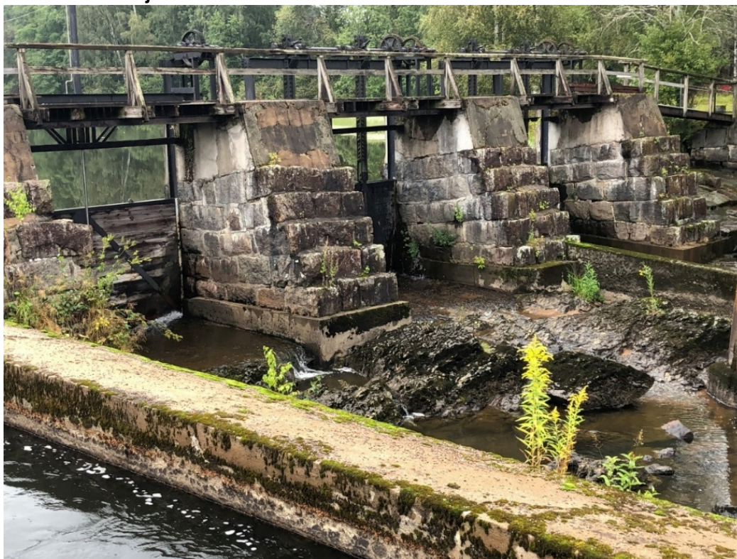
Figur 4. Demningen ved Rotnes Bruk 16 august 2019. Bildet viser damkonstruksjonen med damluker, og inntakskanalen som leder vann via en rørledning til kraftverket ca. 180 meter nedstrøms (Foto: Asle Økelsrud/NIVA).
