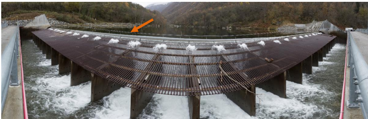
Figur 1. 180° panorama av sperrekonstruksjonen. Dyserørene kan sees rett over brekket der vannet faller ned over sperregitteret (oransje pil). Foto: Anders Gjørwad Hagen/NIVA
