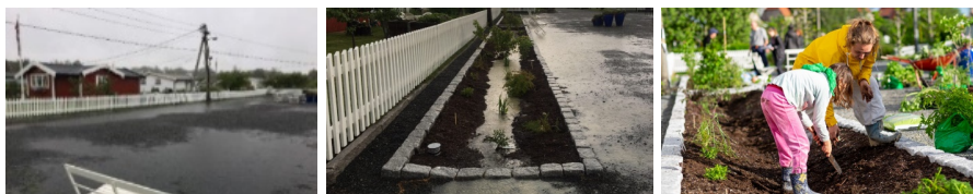
Figur 21. Et av stedene i hagekolonien hvor overvann typisk ble stående og hvor mange ønsket tiltak var på fellesplassen midt i hagen. Her ble det, som et av flere steder, i oppfølgende initiativ og samarbeid etablert regnbed (foto: Line Barkved (venstre, midten), Leidolv Magelssen (høyre)).
