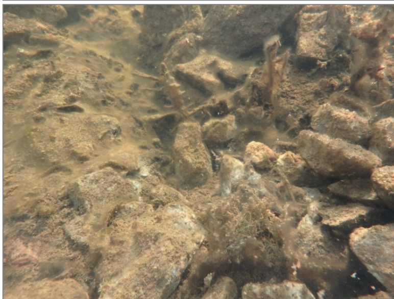
Figur 7. Ytre del av steinfyllingen ligger ute i Svanevatn. Steinene er dekket med et tynt slam-lag i tillegg til kalkutfelling og algebegroing. Noen få planter kan skimtes midt i bildet. Foto: Susanne Schneider/NIVA.
