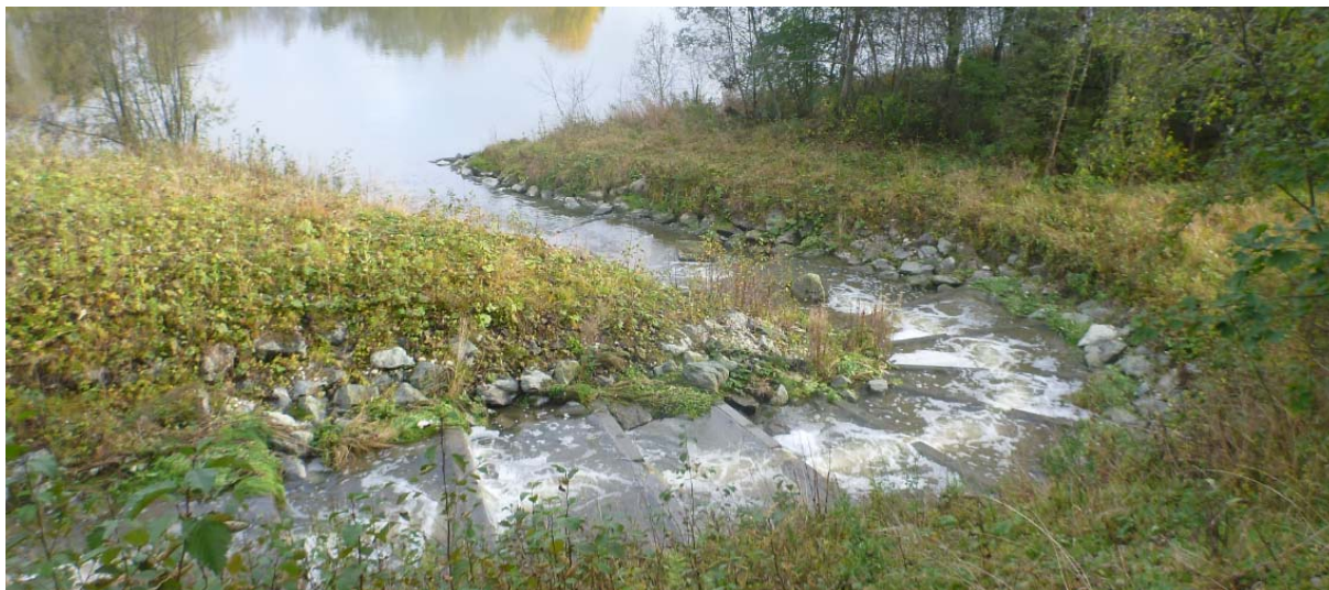
Figur 5. Nedre partier av Sverresdalsbekken etter åpning av bekkeløpet. (Foto: Morten Andre Bergan)
