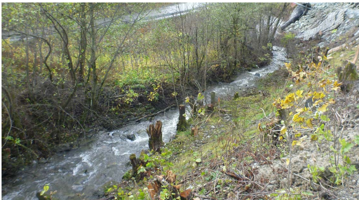
Figur 1. Uglabekken før munning til Leirelva. (Foto: Morten Andre Bergan).
