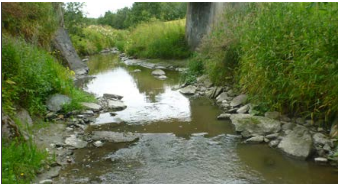
Figur 19. Ristelvas nedre del med stasjon 18. Foto: Morten Andre Bergan.
