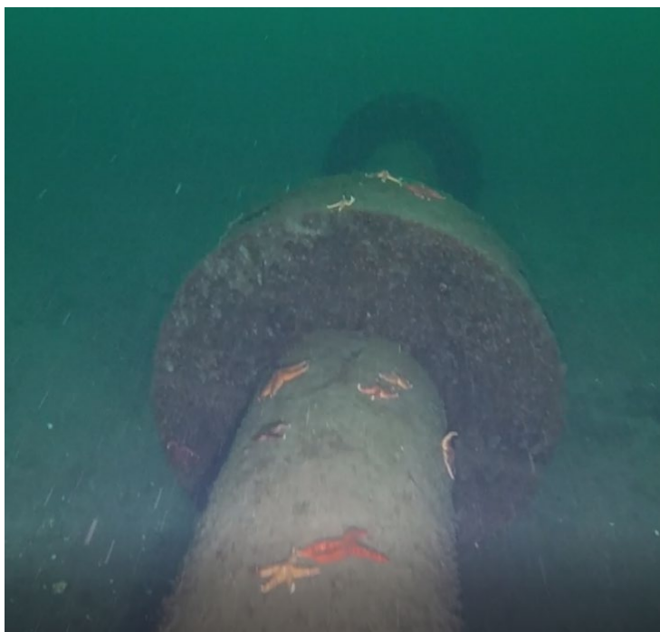
Figur 3. Tenkt utslippsledning fra Frier Tråk med 8m PE røreneheter og med betonglodd i skjøtene. Bilde fra Sørffjorden.
