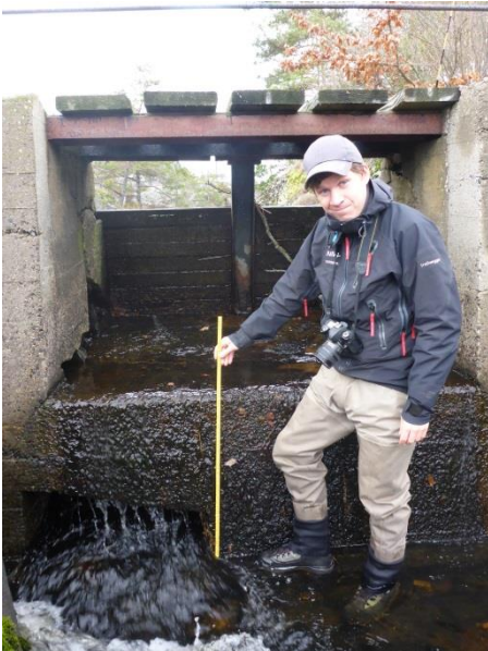
Figur 44. Det vestlige løpet i Leivasselva har en ødelagt laksetrapp(øverst) mens det østlige løpet har oppgang av sjøaure og fisken kan muligens vandre opp bunnløpet.
