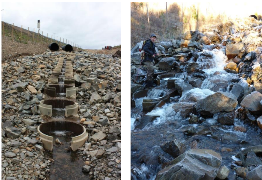
Figur 16. Fiske-trapp mot kulvert under E-18 i 2010 (Gustavsen 2010) og høsten 2013.
