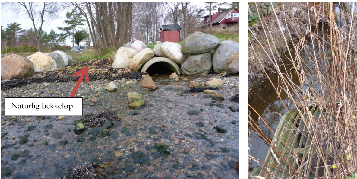
Figur 25. Hovedvannføringen i Kvennevikbekken går i rør gjennom store deler av den anadrome strekningen. Inntaket (h) og utløpet til sjøen (v).
