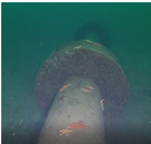
Figur 3. Tenkt utslippsledning fra Vianode med 6m PE røreheter og med betonglodd i skjøtene. Bilde fra Sørfjorden.
