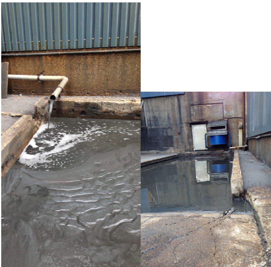
Figur 3. Rør for utslipp av vaskevann til utjevningsbassenget. Utløpet fra bassenget (høyre bilde) er et overløp i høyre hjørne i nærmeste bildekant.
