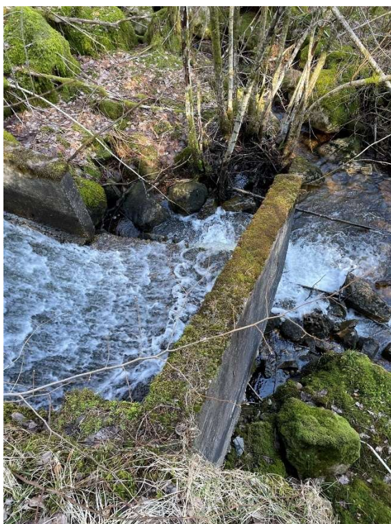
Figur 28: Betongkonstruksjoner ved eldre vanninntak fungerer i dag som vandringshinder for ørret samt vanskelig forserbar for ål. Foto: NORCE.
