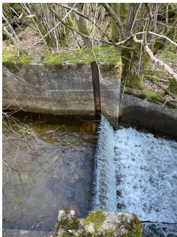
Figur 28: Betongkonstruksjoner ved eldre vanninntak fungerer i dag som vandringshinder for ørret samt vanskelig forserbar for ål. Foto: NORCE.
