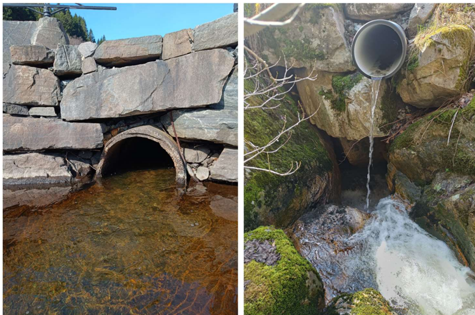
Figur 23: Nedstrøms (venstre) og oppstrøms del av ulver under fylkesvei 465. Foto: NORCE.
