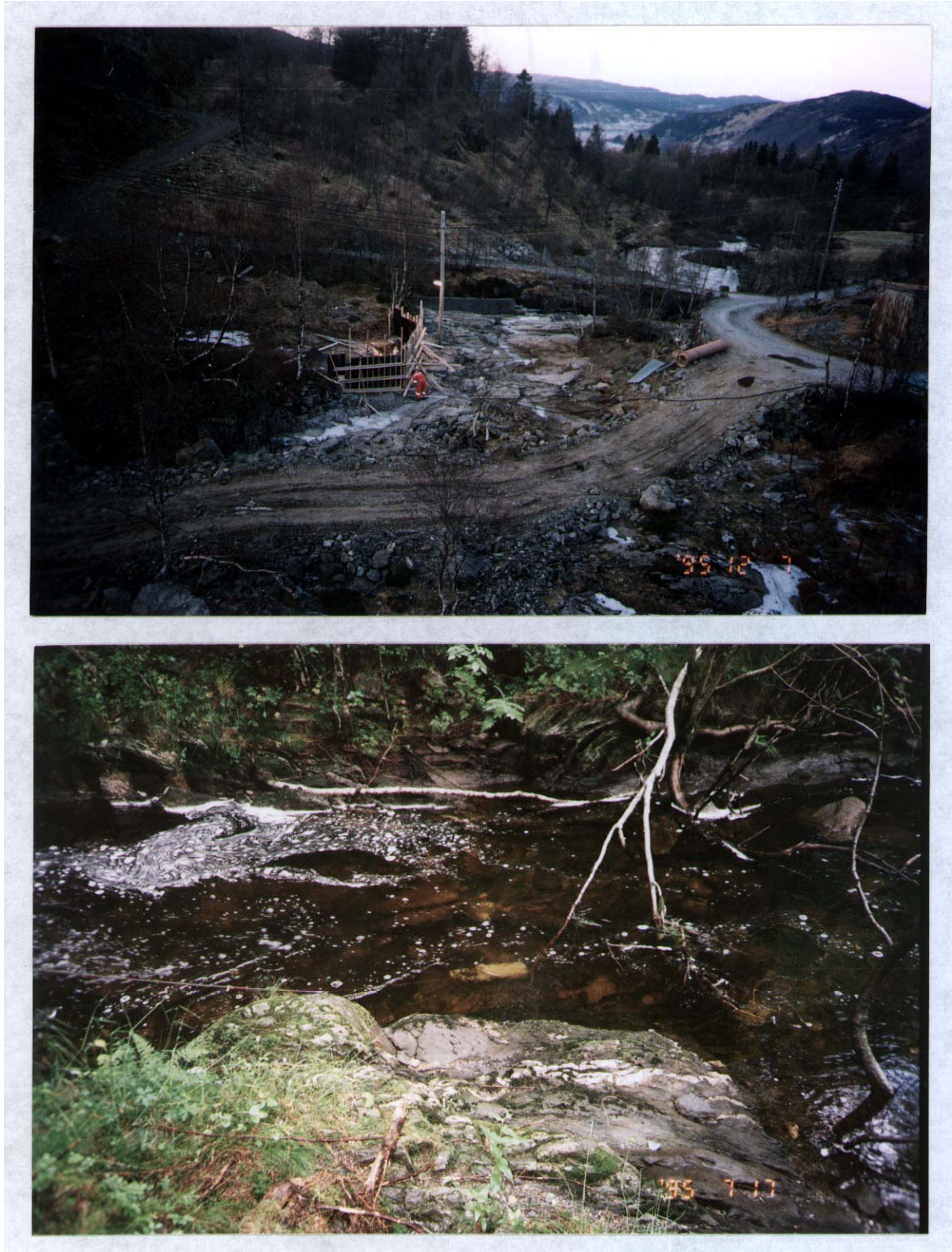
Figur A5. Øverst: Fra anleggsarbeidet oppe ved angrepspunktet for trykksjakta, desember 1995. Nederst: Temperaturlogger plassert midtvegs oppe i Skulstadelva, like ovenfor det gamle inntaket til kraftverket ved Sætevad (kote 164).
