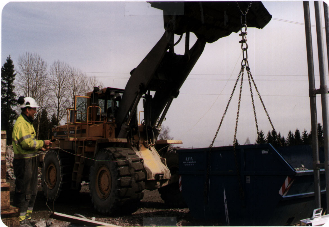
Figur 5. En kontainer med tunnelmasse veies.
