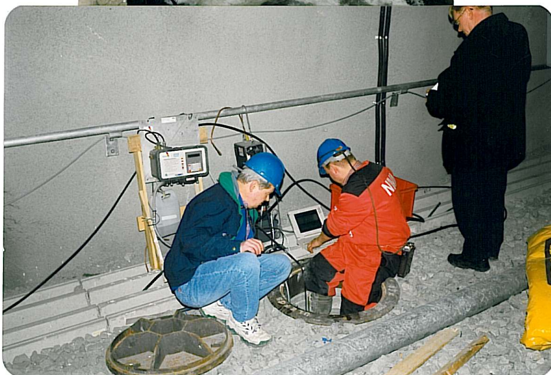
Figur 16. Øverst: Utløpet av tunnelvannet i Alna. Nederst: Vannføringsmåling i kum nær tunnelåpningen.
