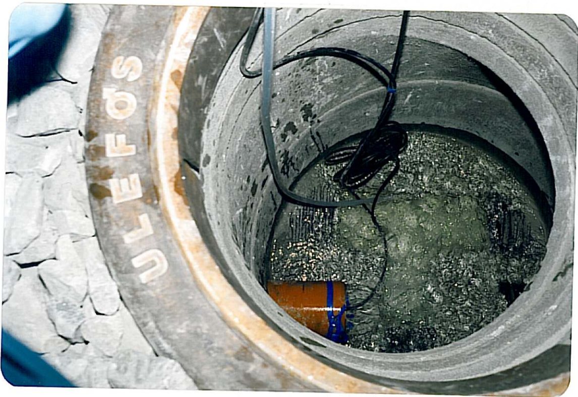
Figur 17. Turbid dredivann under anleggsarbeidet (øverst) og klart dredivann etter avslutningen (nederst).
