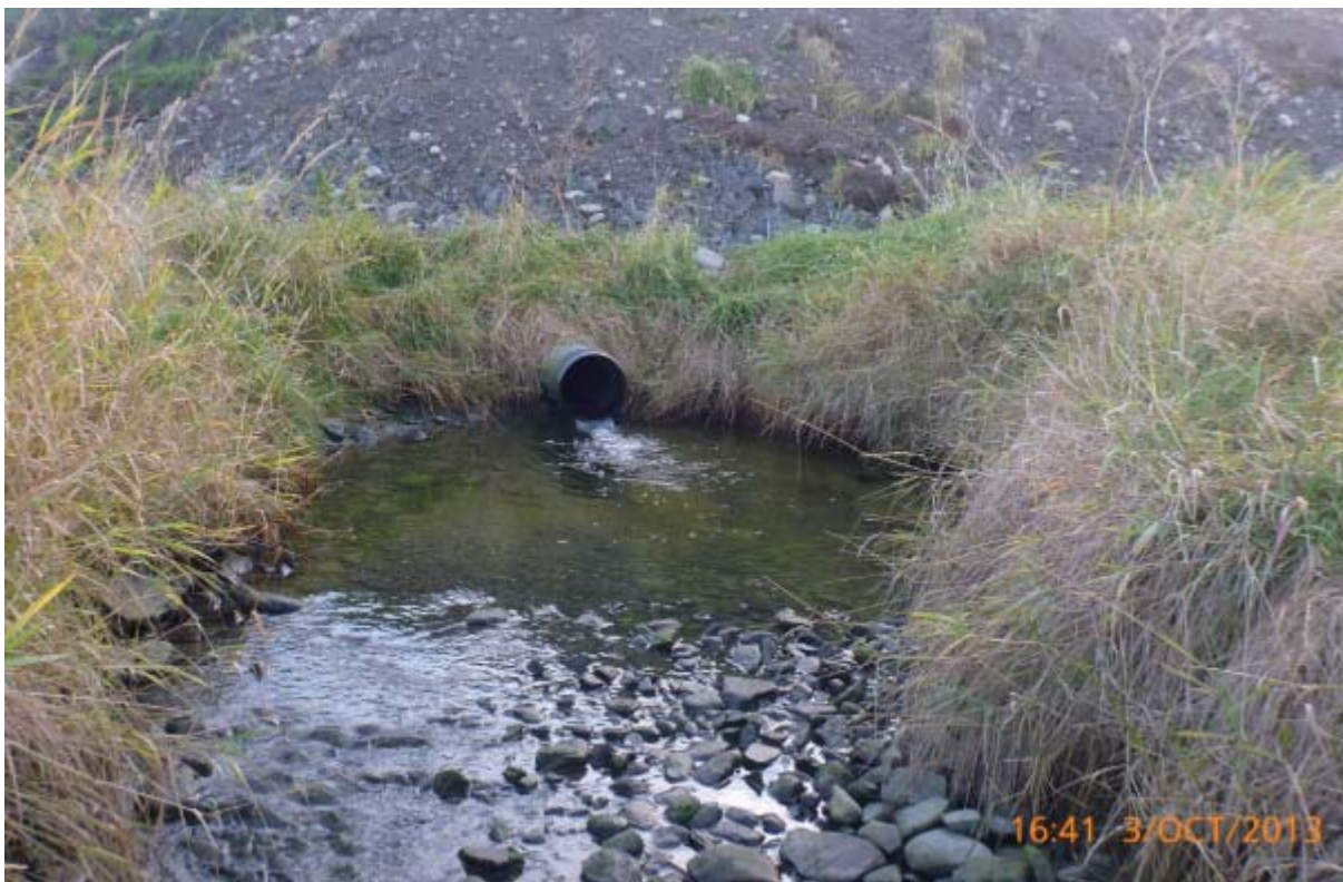
Figur 6. Vellesveita. Rør-munning like før sjø. (Foto: Morten Andre Bergan)
