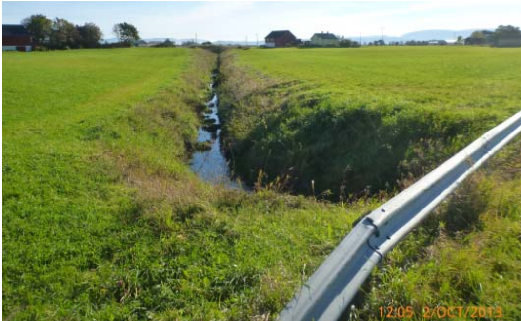
Figur 17. Meldalsbekken ovenfor Fv 243 i dag. Fotoet viser senket og utrettet kanal, lik hele dagens åpne strekning. (Foto: Morten Andre Bergan)
