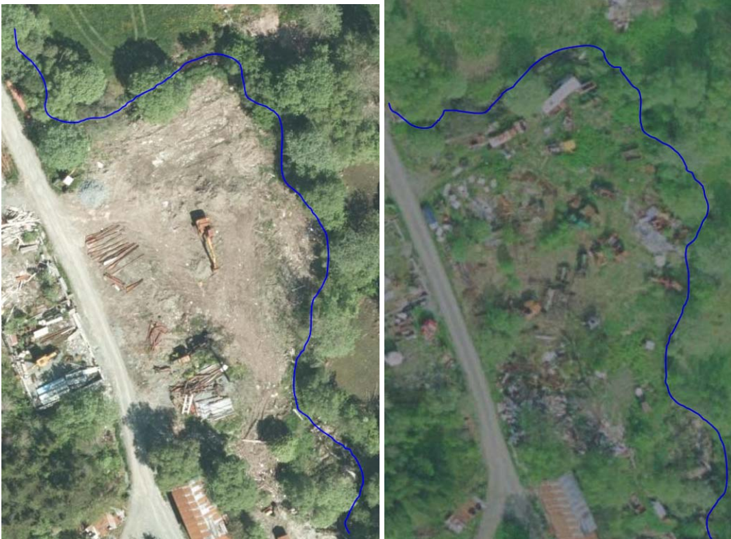
Figur 59. Deponi ved Kalvåbekken. Større mengder ukjent avfall kan være deponert og nedgravd (?) like ved bekkeløpet nedstrøms Fv 231. Flyfoto fra 2012 (t.v.) og 2004 (t.h.).
