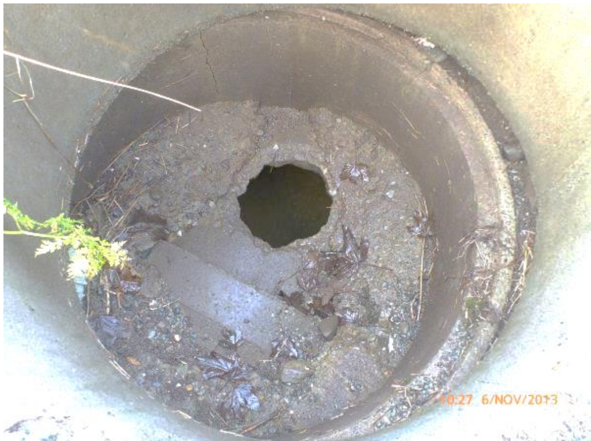
Figur 35. En kum med hull ned til det som i dag er Vikagrøfta/Vikakanalen. Dette er eneste prøvetakingsmulighet i dette vassdraget i dag. Hele systemet er lukket og lagt i bakken. (Foto: Morten Andre Bergan).
