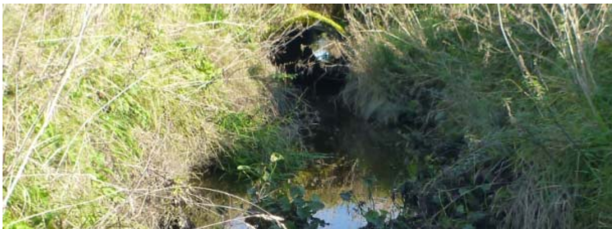
Figur 16. Veikrysning med godt nedsenket kulvert under Fv 244. (Foto: Morten Andre Bergan)
