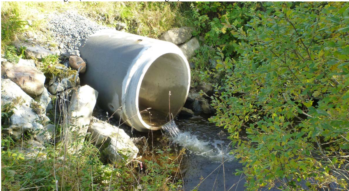
Figur 49. Kulvertutløp nedstrøms Fv 213 i Karlsengbekken. Sprang opp til kulvert på liten og middels vannføring. (Foto: Morten Andre Bergan)
