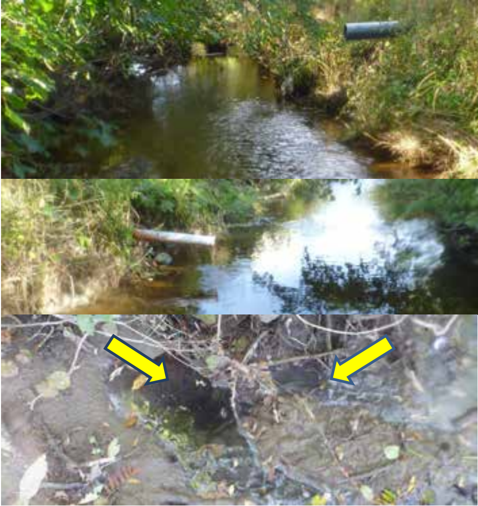
Figur 42. Drensrør fra nærliggende jordbruk og illeluktende sig (gule piler) langs vassdragskanten fra punktutslipp forekommer hyppig i dette partiet av Balsneselva. Vassdraget luktet silo under befaringen (Foto: Morten Andre Bergan).
