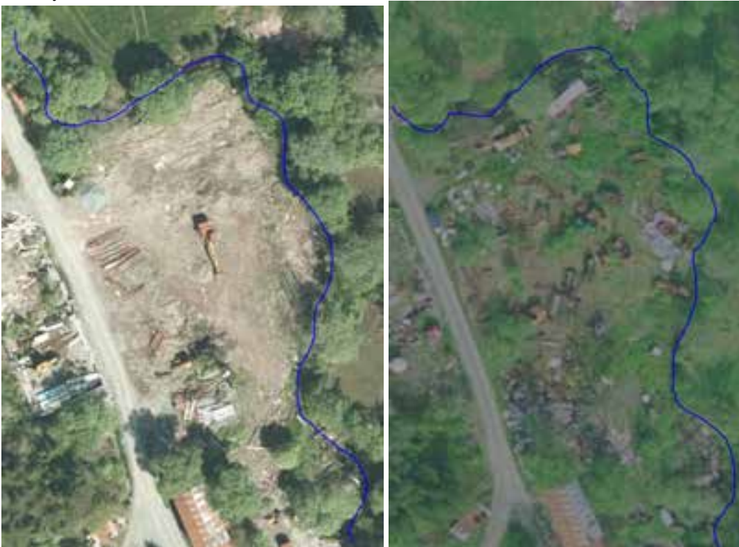
Figur 59. Deponi ved Kalvåbekken. Større mengder ukjent avfall kan være deponert og nedgravd (?) like ved bekkeløpet nedstrøms Fv 231. Flyfoto fra 2012 (t.v.) og 2004 (t.h.).
