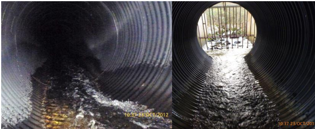
Figur 82. Foto inne i kulvert under gamle E6. Foto fra overside ved Rema 1000. (Foto: Morten Andre Bergan)
