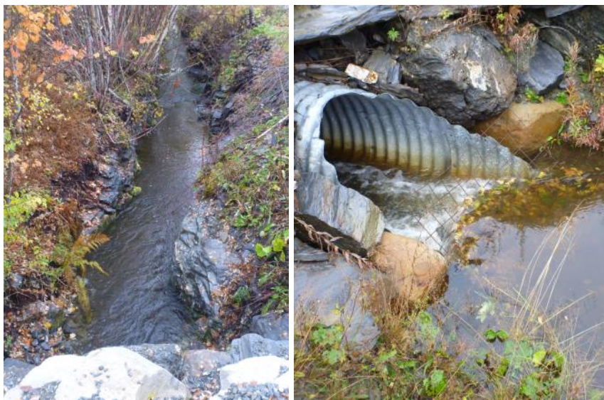
Figur 20. Stasjonsområde 6 b i midtre del av Låbekken (t.v.), og krysning under nyanlagt vei (t.h.) i nedre del av Låbekken (stasjonsområde 6a) (Foto: Morten Andre Bergan).
