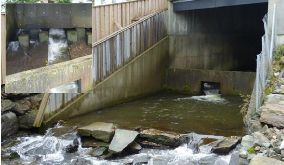
Figur 81. Nederste kulvert i Vikhammerelva ved utløp nedstrøms gamle E6. (Foto: Morten Andre Bergan).
