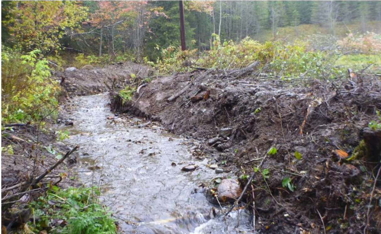
Figur 29. Kjelstadbekken like ovenfor Fv 964 (Foto: M. Bergan).
