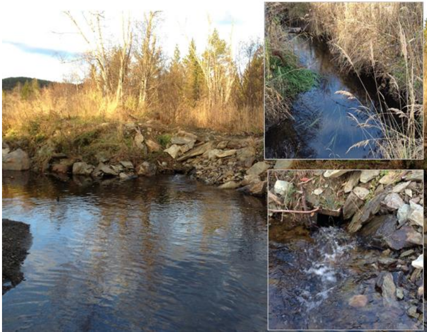
Figur 102. Utløpsbekk fra Tjønnåstjønna til Sneiselva/Vennelva er sperret for fiskevandring som følge av anlagt traktorvei.
