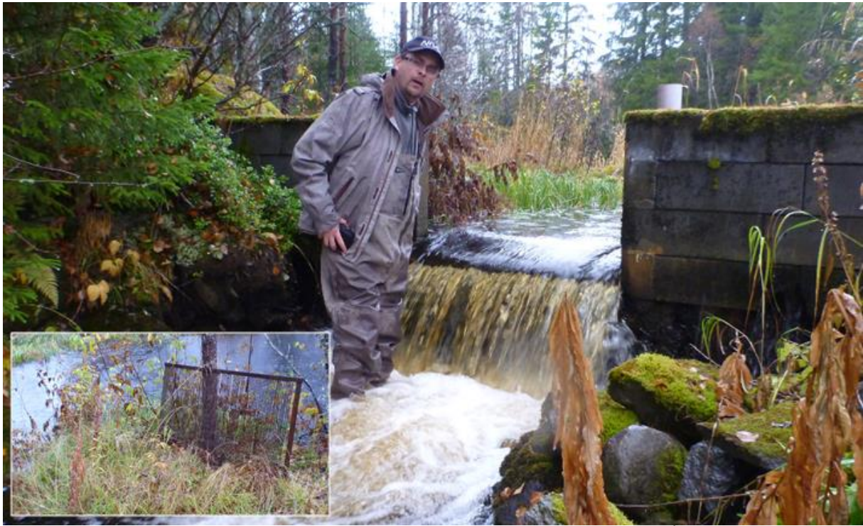
Figur 13. Menneskeskapt vandringsbarriere i Krokbecken før munning til Nea. Åpningen i steindemningen kan sperres med rist (innfelt foto) (Foto: Hans M. Berger).
