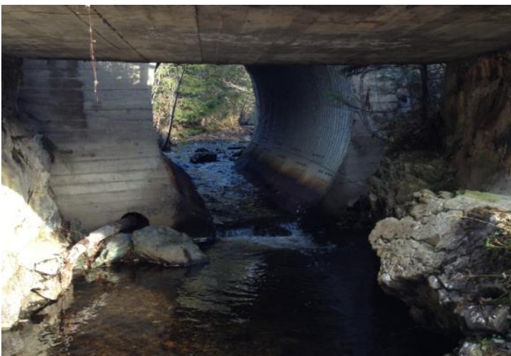
Figur 78. Kulvert under FV 963 i Lauva til Vikaelva. Passerbar for fisk i flere størrelser, men ikke optimalt utformet mht fall og vanddybde.
