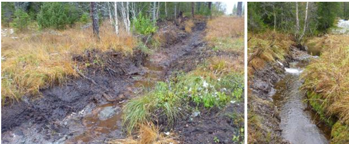
Figur 5. Utstrakt grøfting i deler av bekk fra Fellmannsmyra i forbindelse med etablering av skiløyper (Foto: M. Bergan).
