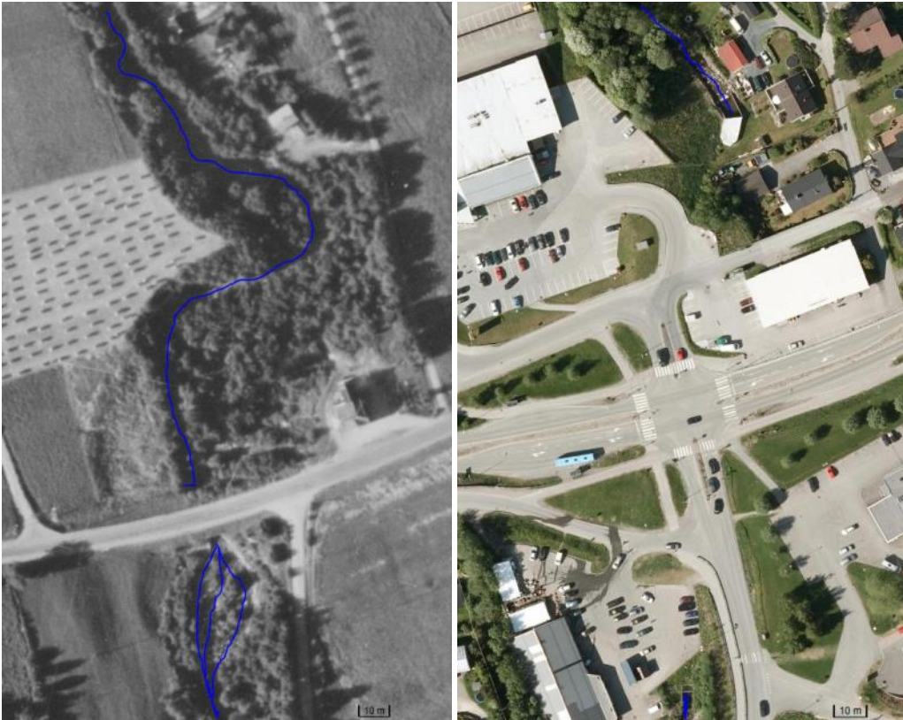
Figur 98. Flyfoto over problemkulvert under Fv 950/Gamle E6 fra 1947 (t.v.) og 2010 (t.h.). Lett forbivandring historisk; vandringsbarriere i dag. Flyfoto hentet fra http://kart.finn.no/ .
