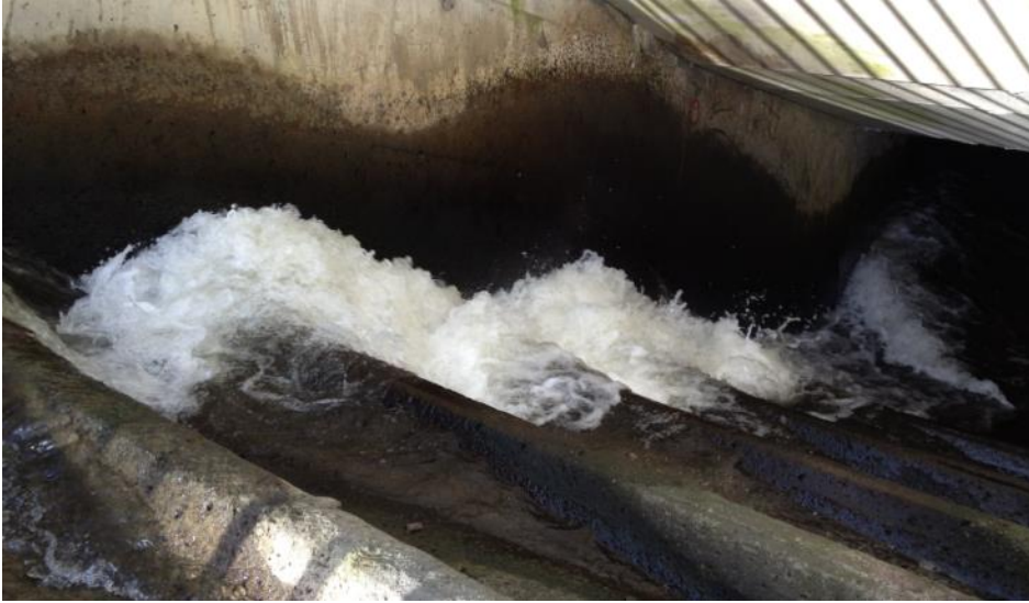
Figur 97. Uheldig konstruksjon for oppvandring av sjøørret under dagens E6. Dette må utbedres ved anlegging av ny E6. (Foto: Hans Mack Berger).
