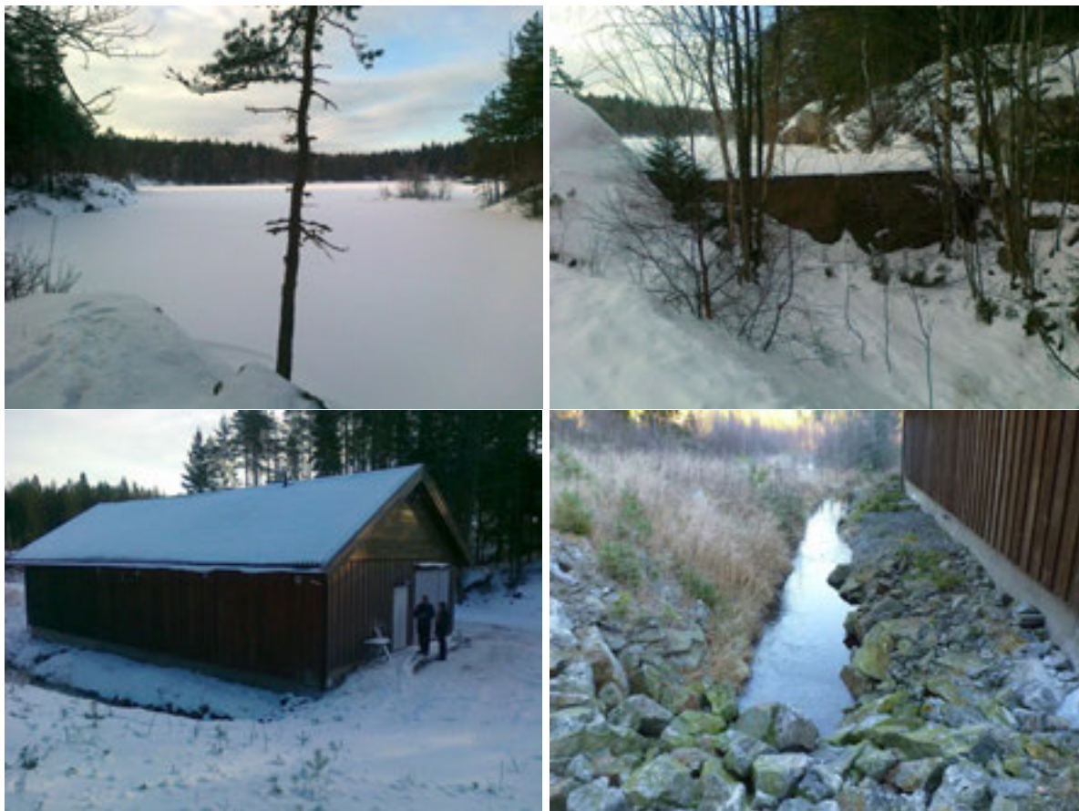
Figur 1.2. Vannbehandlingsanlegget ligger like nedenfor dammen. De øverste 50 m av Rusvikbekken er tørr, da hele avrenningen fra Rusviktjernet tas inn i vannverket. Bekken føres kun av spylevann fra membranfilteranlegget, med unntak av korte perioder med overløp over dammen. Foto: Dag Berge (de tre øverste), Torleif Bækken (nederst til høyre).
