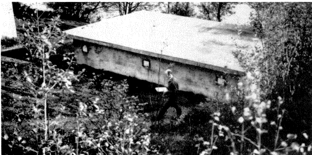
Kaland skoles renseanlegg.
