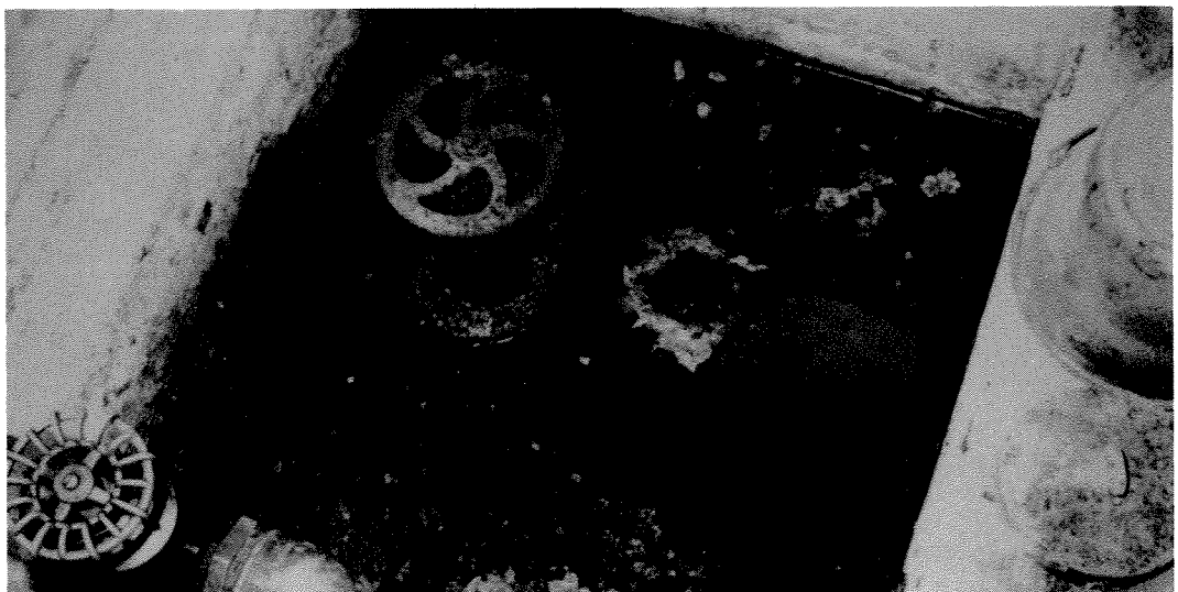
Regnvannet går inn på anlegget gjennom denne åpningen i tilførselsledningen.
