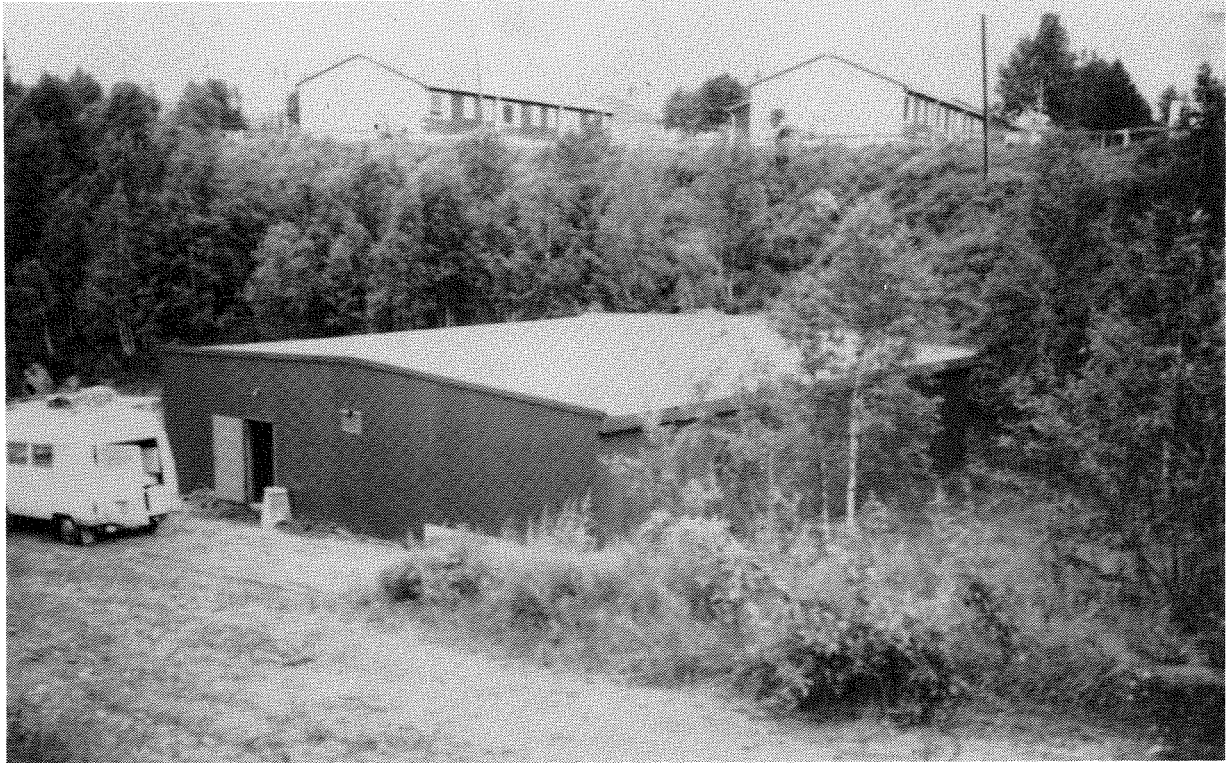
Nyleiren/Bardufoss flystasjons rense- anlegg.
