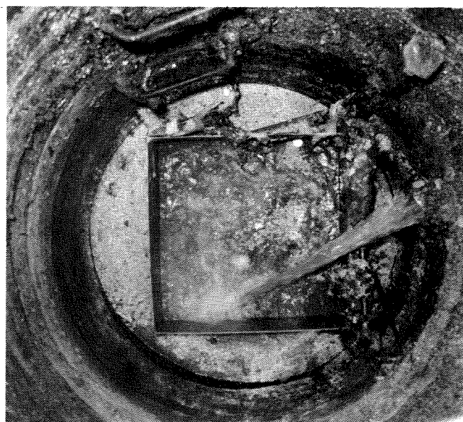
Kum foran renseanlegget hvor det kunne plasseres en ristkurv.
