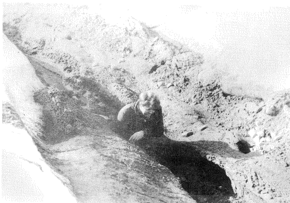
Fotografi 6. Dype raviner oppsto i løsmasseskråninger ned mot magasinet som dannet erosjonsbasis.
