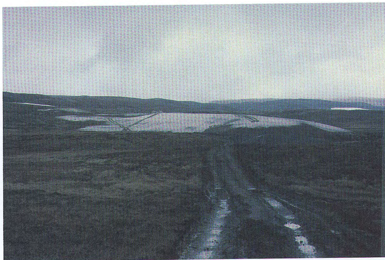
Bilde 4. Velte 2 har fått den endelige form og var ferdig kalket 20/9-81. I alt ble kalket med 100 tonn hydratkalk.
