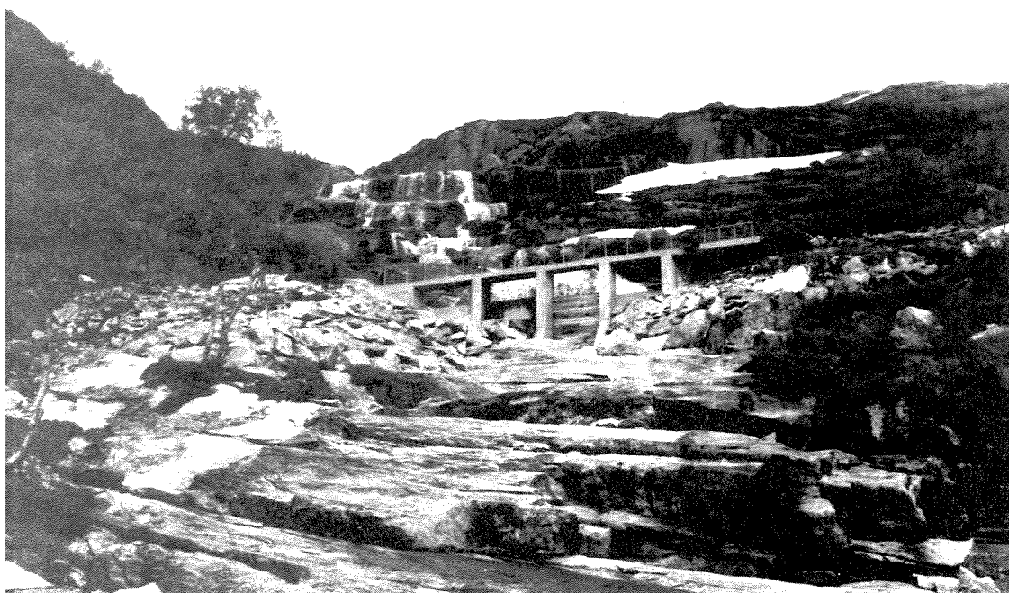
Vanninntak i elva fra Norddalen under Krosstølen (Nygård). Krosstølen ligger oppe på platået i bakgrunnen.
