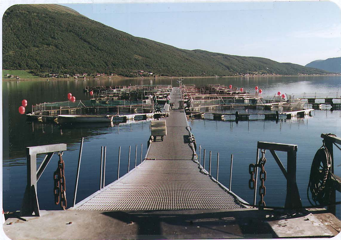
Figur 1b Akvaprodukt A/S, med oversikt fra land og ut over anlegget.
