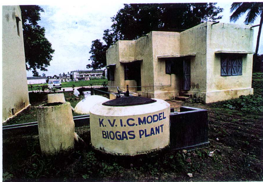
Figur 28 Demonstrasjonsanlegg for biogass på 1 ha. areal.
