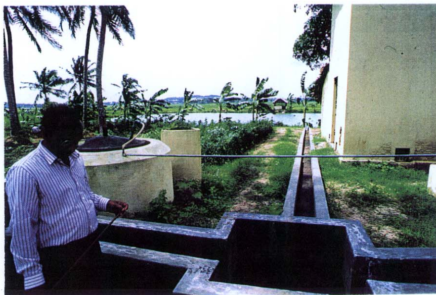
Figur 30 Biogassen føres over til kjøkkenenheten mens den utgjærede gjødslen renner ut i fiskedammen.
