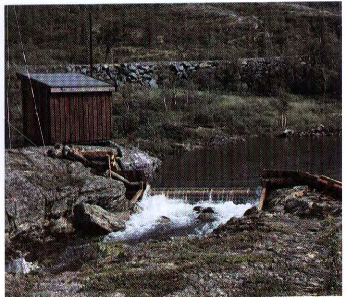
Målestasjon for vannkvalitet. Utløp Store Skorovatn.
