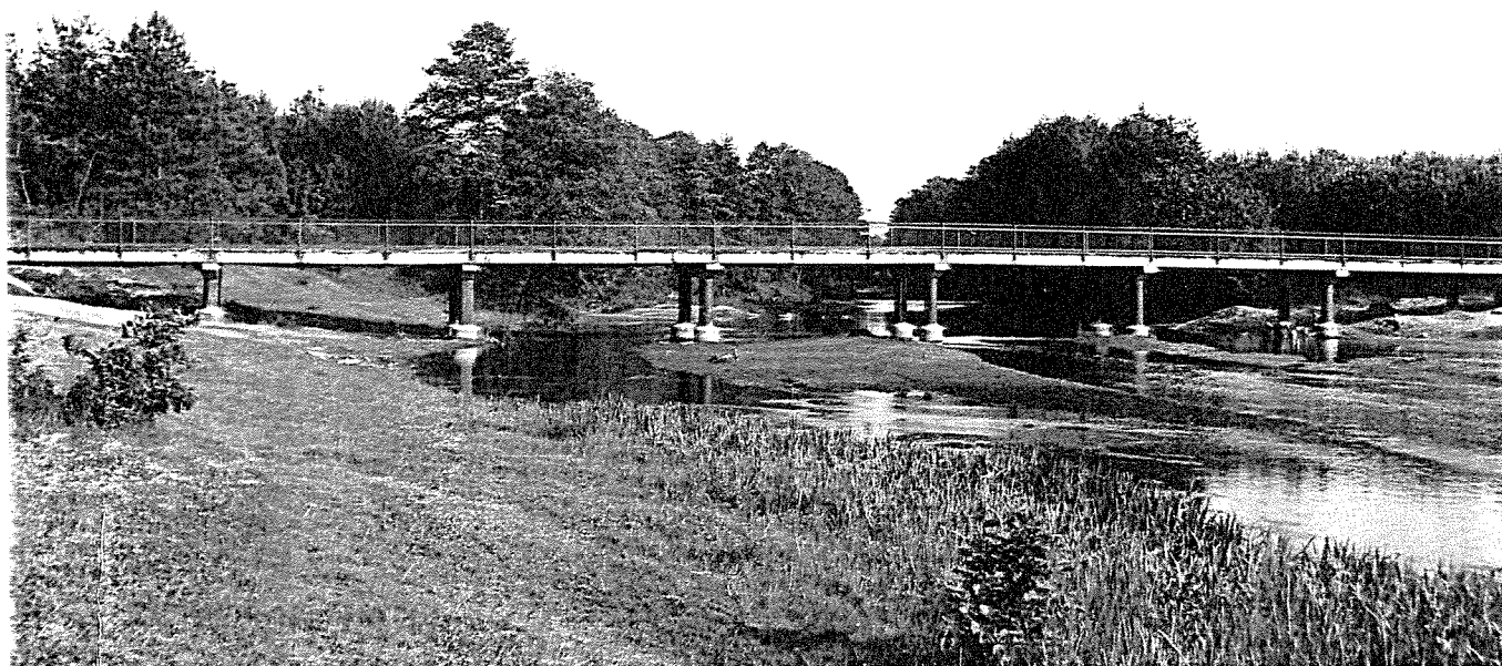
Most prefabrykowany systemu "Poltegor" (rzeka Świder, nośność 30T, L=80 m). Inwestor - WZDiM - Otwock
